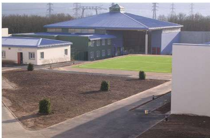
Etablissement pénitentiaire pour mineurs (EPM) de Porcheville
